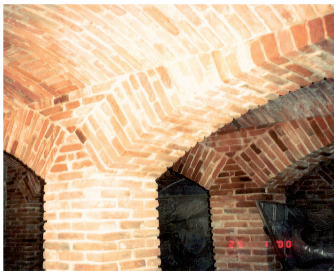
Tragkonstruktion aus Arkaden- und Segmentgewölbe
